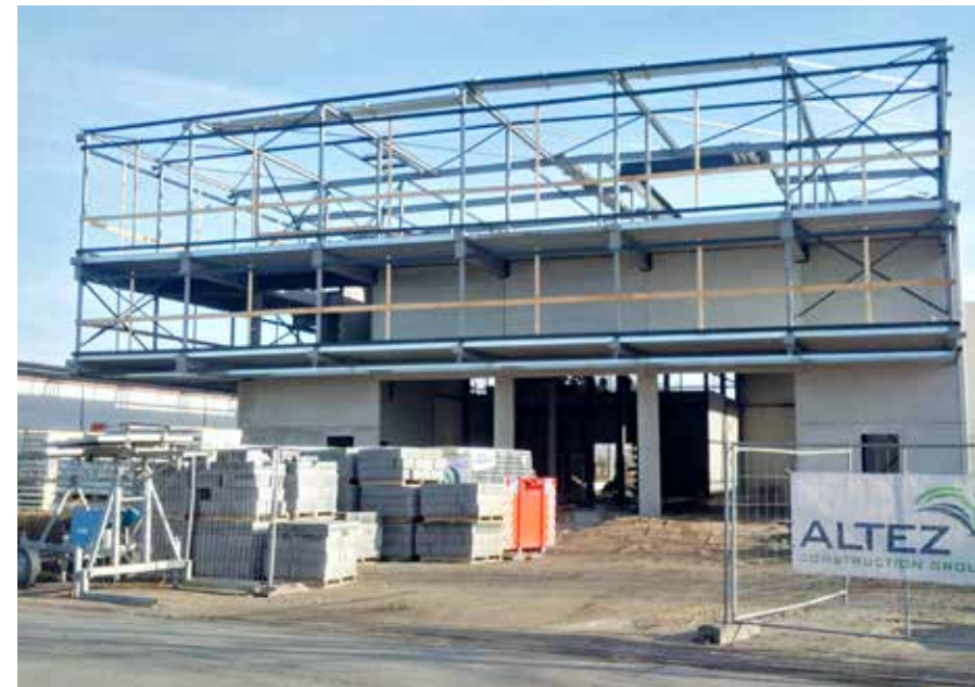
: "De onderdelen van de beton-staalbouw zijn stuk voor stuk geproduceerd in onze fabriek in Meeuwen, met uitzondering van de gewelven in de ruwbouw", aldus Philippe Van Wanseele.
